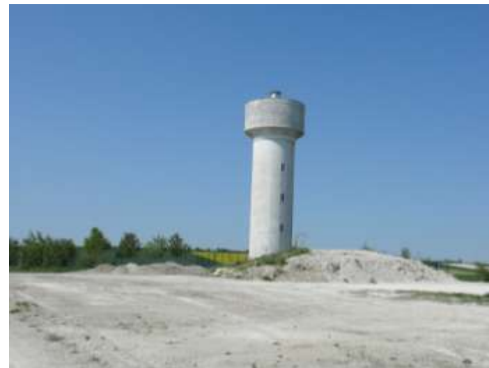
C2. Stockage de matériaux inertes
